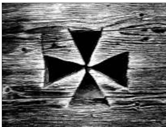
Tradicioniai (dažniausiai grūdinėse ir kamarose) sienajuose išpaunami langeliai gali būti įvairių formų – rombiniai, apskriti, pusapskritiniai, stačiakampiai
