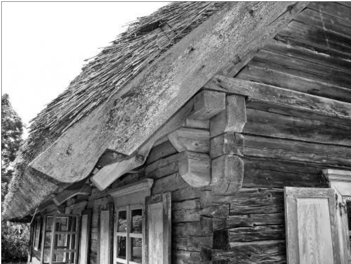
Vienas populiariesnių sienojų jungimo kampuose būdų Žemaitijoje buvo jungimas į kertes (raktą, capą), santūriai dekoruojant viršutinių sienojų sujungimo kampus, gegnių galus. LLBM
