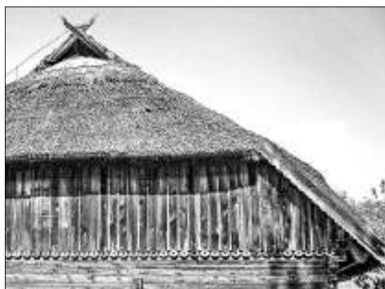
Dekoruotos vėjalentės ir stogo skliauto apkalo apačios galai žemaitiškoje troboje. LLBM
